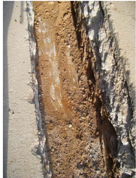
FOTO 02 – Detall on podem apreciar el formigó que cobria una línia de telefònica a la cota màxima de la rasa
