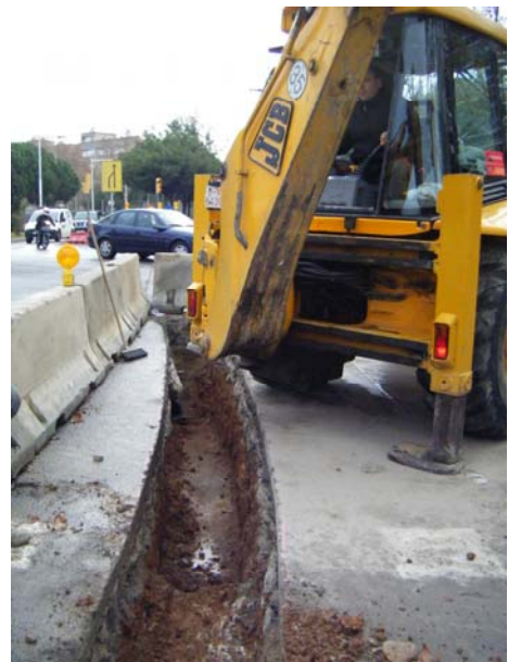
FOTO 04 – Vista de la zona nord-est de la rasa, a tocar del carrer Ramon Trias Fargas, on podem apreciar el nivell de formigó que apareixia a la cota màxima
