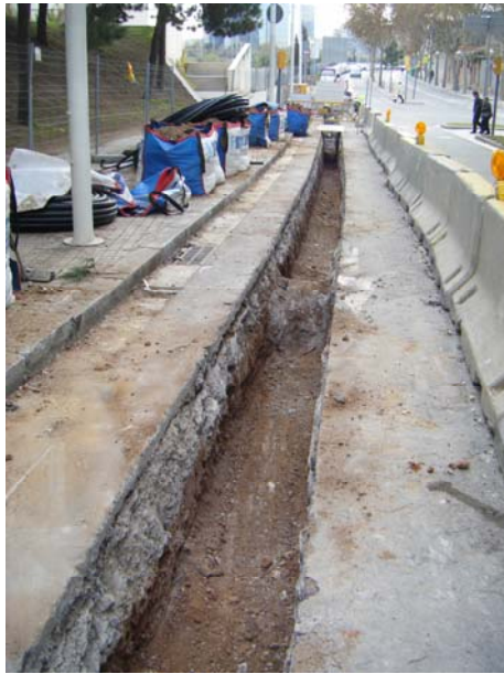
FOTO 01 – Vista general de l'últim tram de la rasa a prop del carrer Wellington
