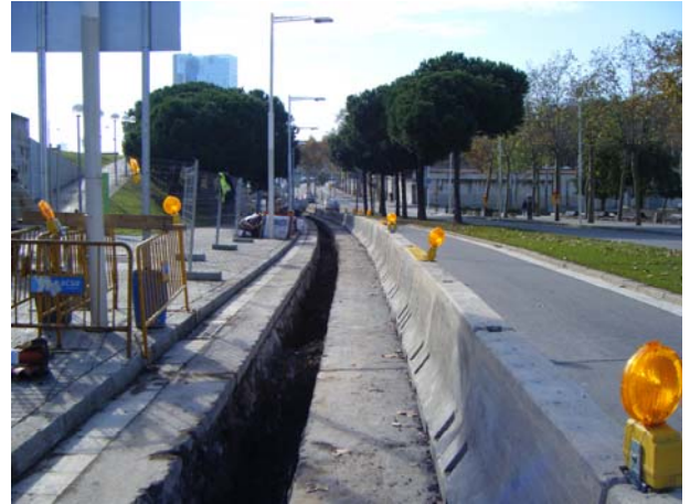
FOTO 6. Vista general de la zona on s'ha desenvolupat la intervenció
