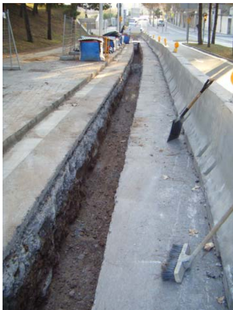
FOTO 03 – Vista general de la rasa en direcció sud-oest
