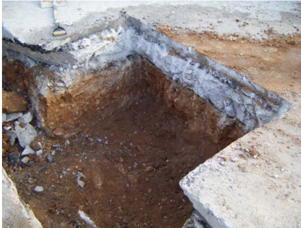
FOTO 5. Excavació per a instal·lar una arqueta
